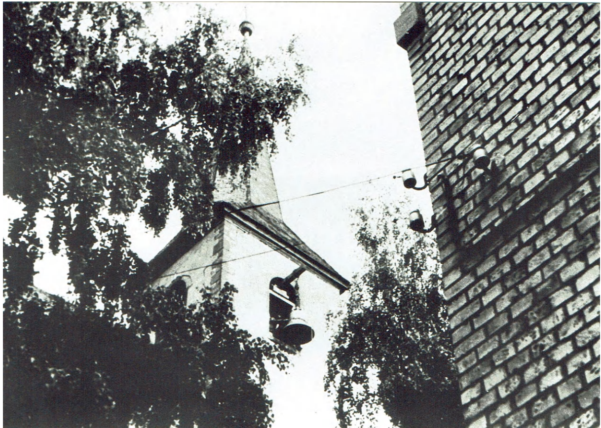
1933 wird eine der beiden gestifteten Glocke am Glockenturm hochgezogen
