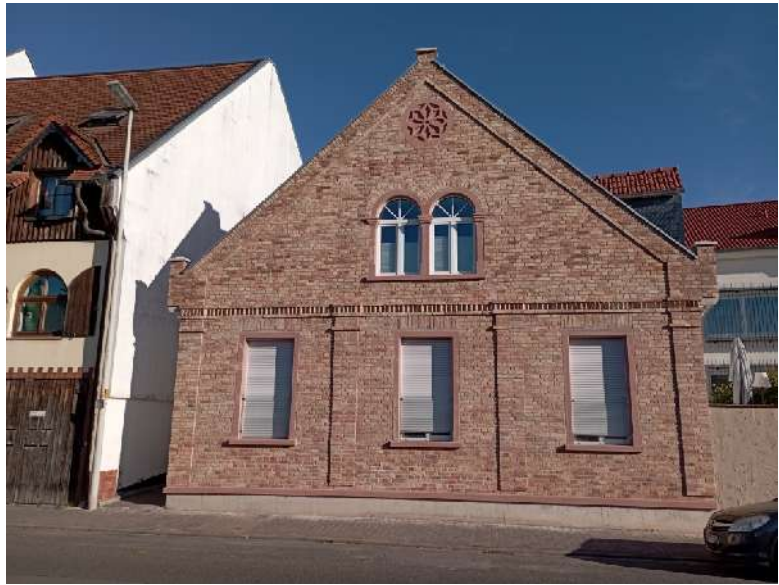
Gebäude nach dem Wiederaufbau 2023
