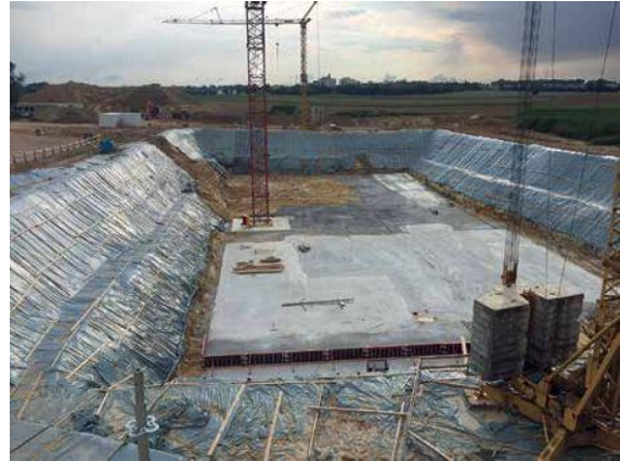
Becken 2, Foto M. Gill vom Bau 2017
