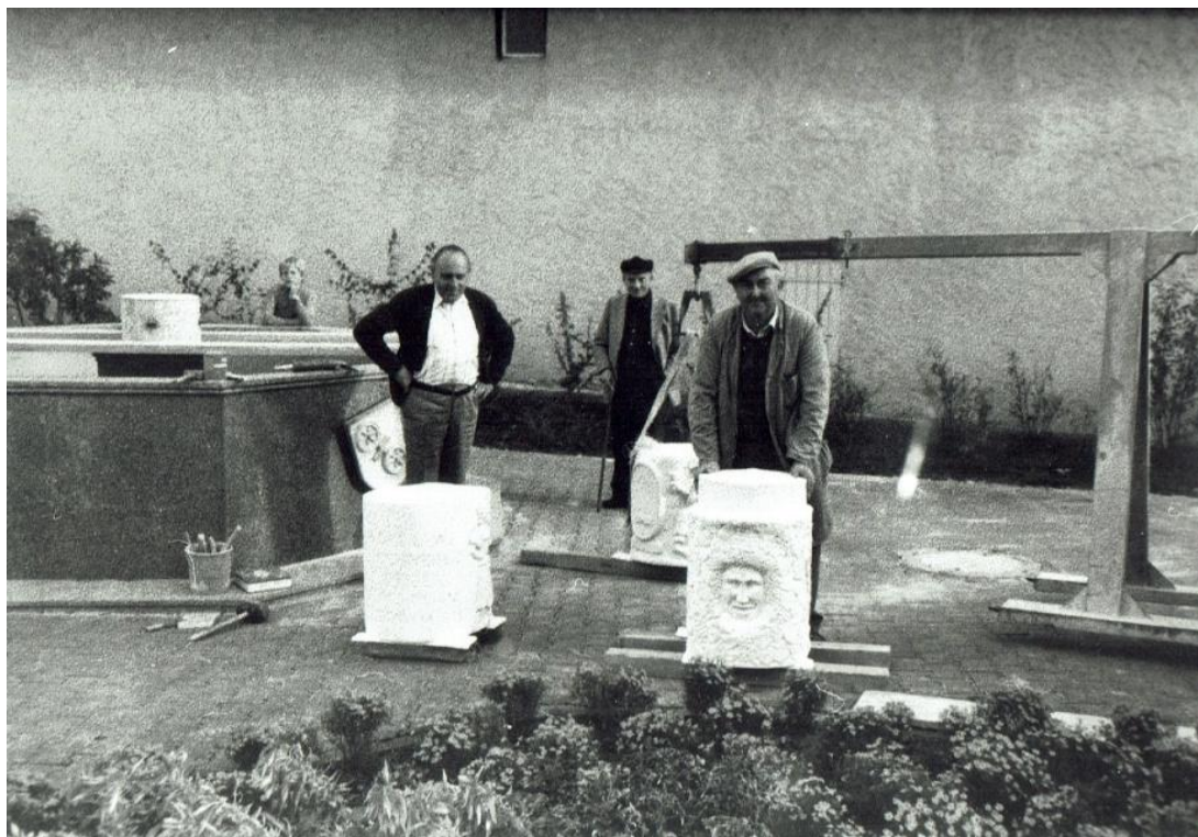
Foto vom Aufbau des Brunnens 1980
